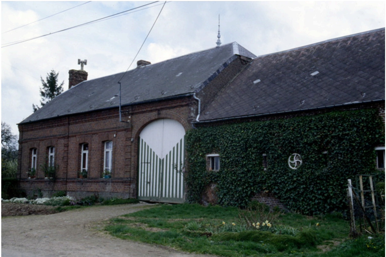
Élévation sur rue du logis et de l'étable attenante.
