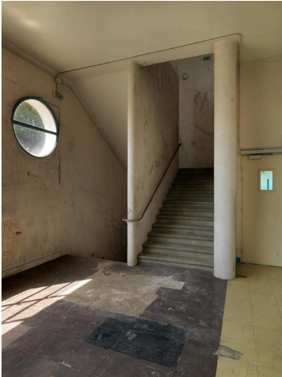
Palier du premier étage et accès aux escaliers
