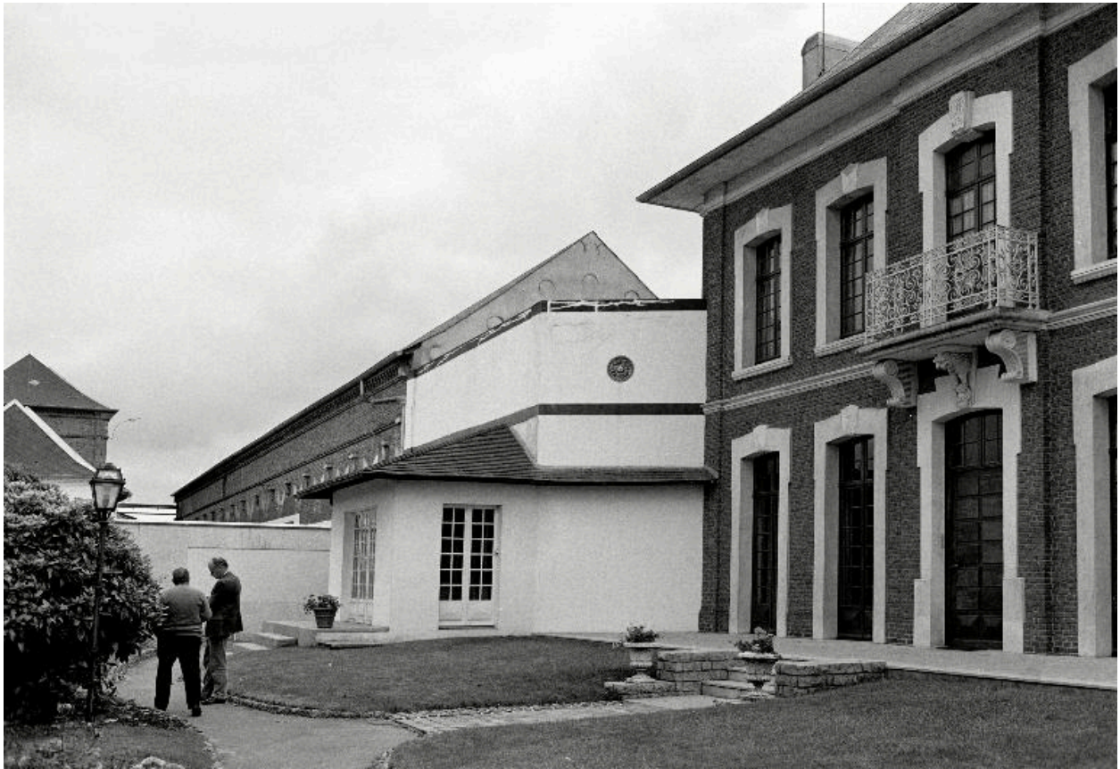
Le logement patronal, 3 rue Gambetta, en 1990.
