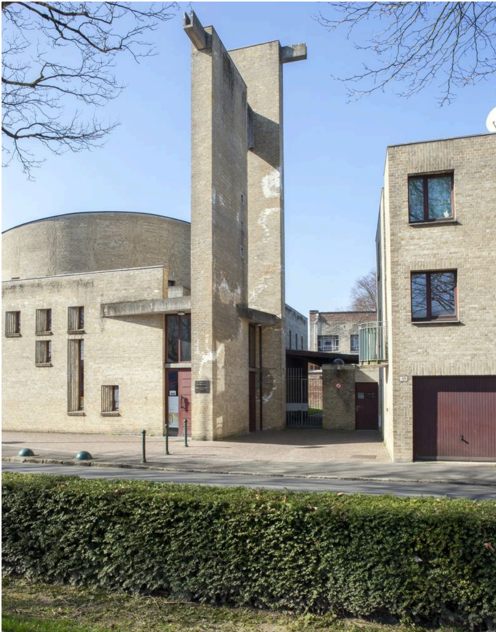
Élévation antérieure de trois quart droit, entrée de l'église.
