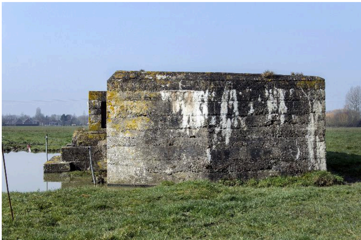
Vue latérale vers l'ouest
