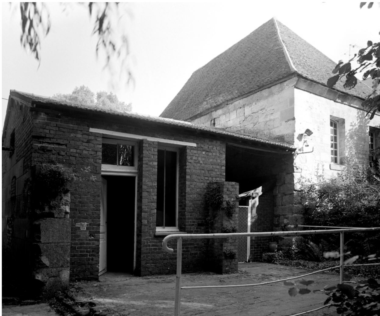
Façade sud de la salle des machines et de l'atelier de fabrication en pierre de taille.
