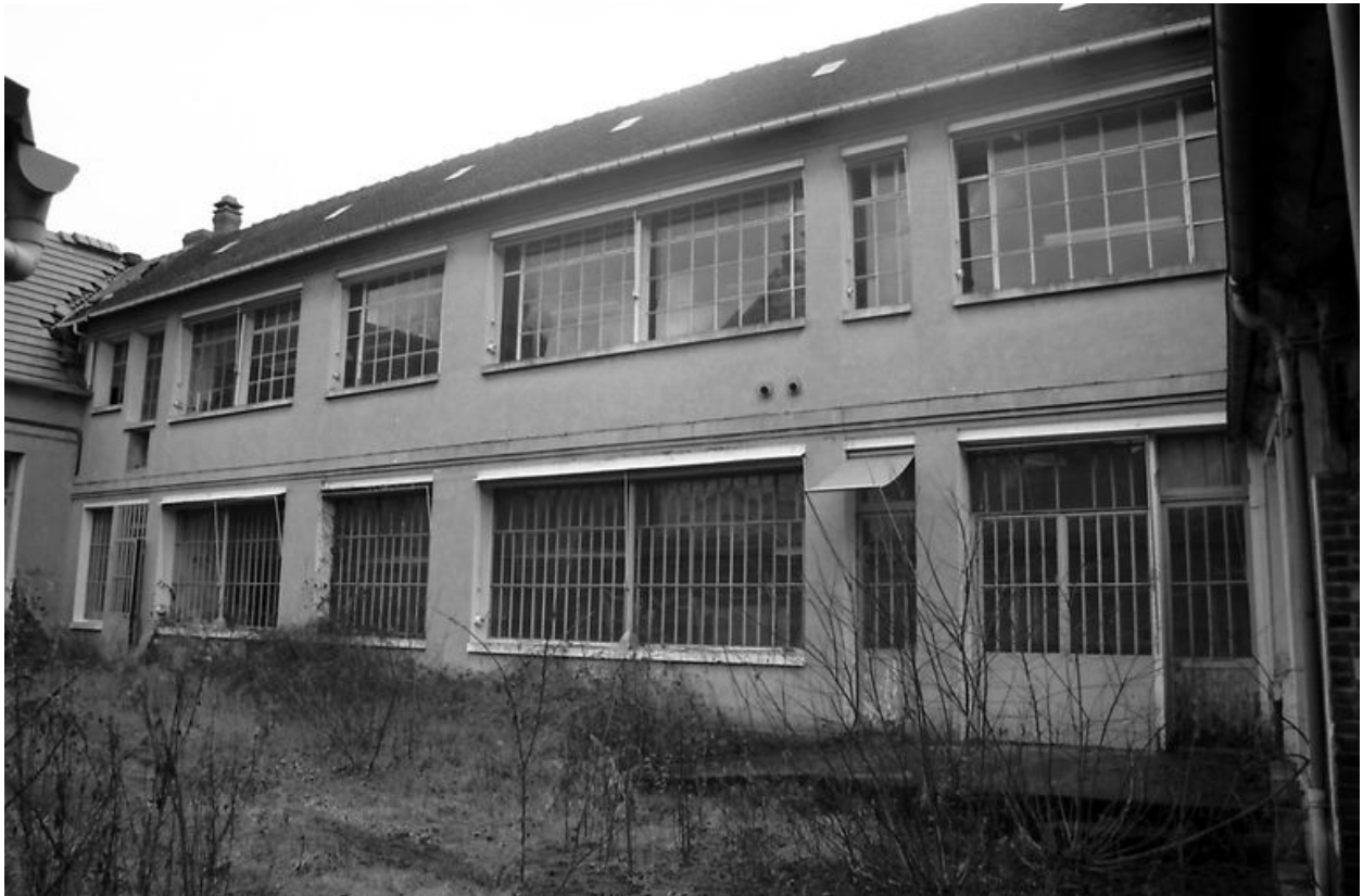
Les ateliers de fabrication, façade sur cour.
