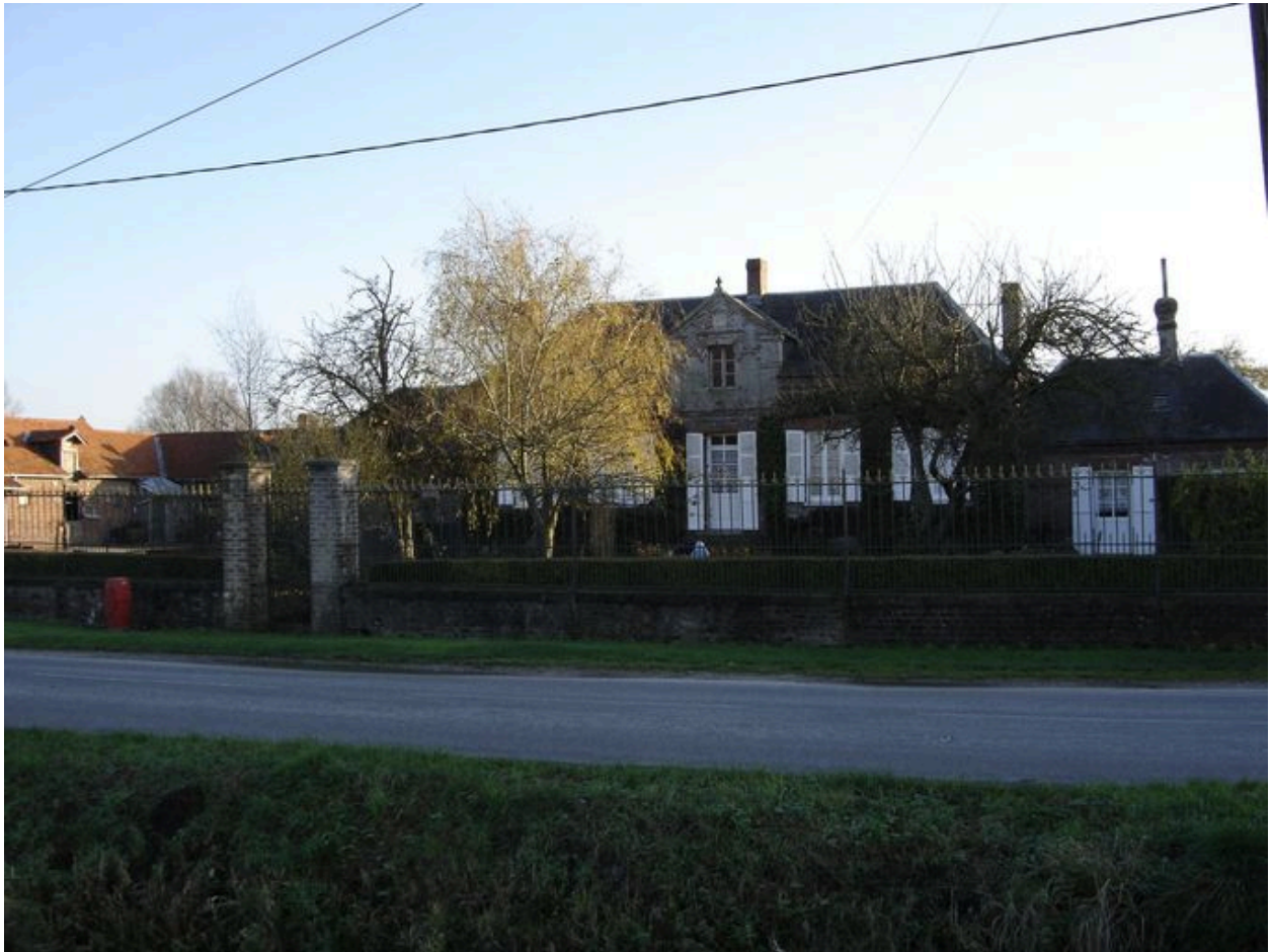
Vue d'ensemble de la façade du logis.
