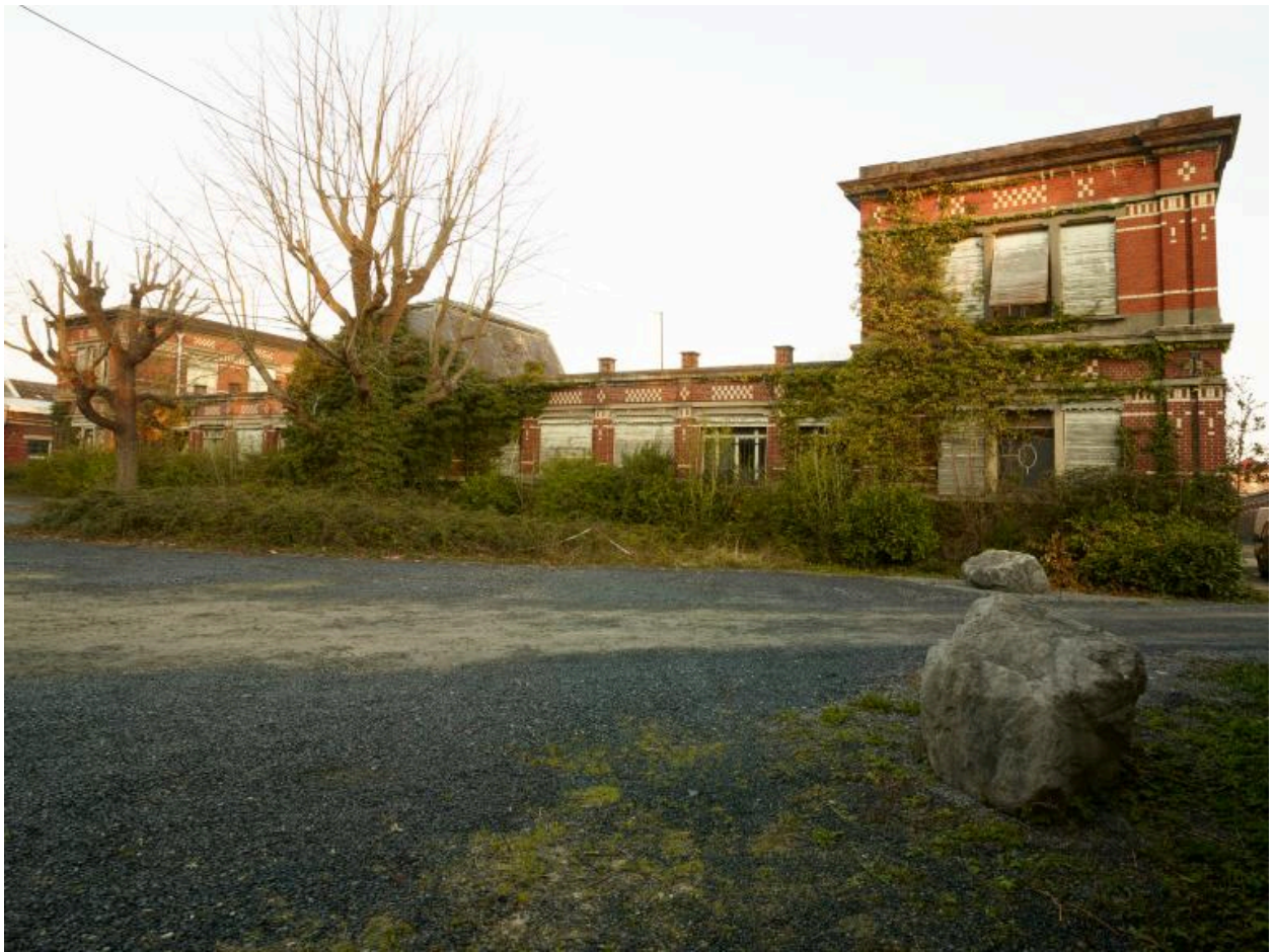
Bureaux. Élévation sur cour. Vue prise vers l'ouest.
