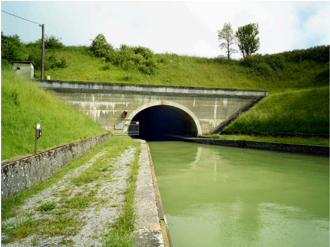
Tête sud et voie de circulation du souterrain.
