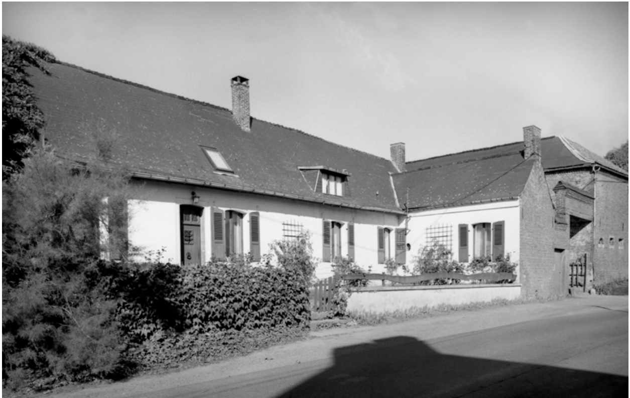
Vue d'ensemble de la façade du logis.
