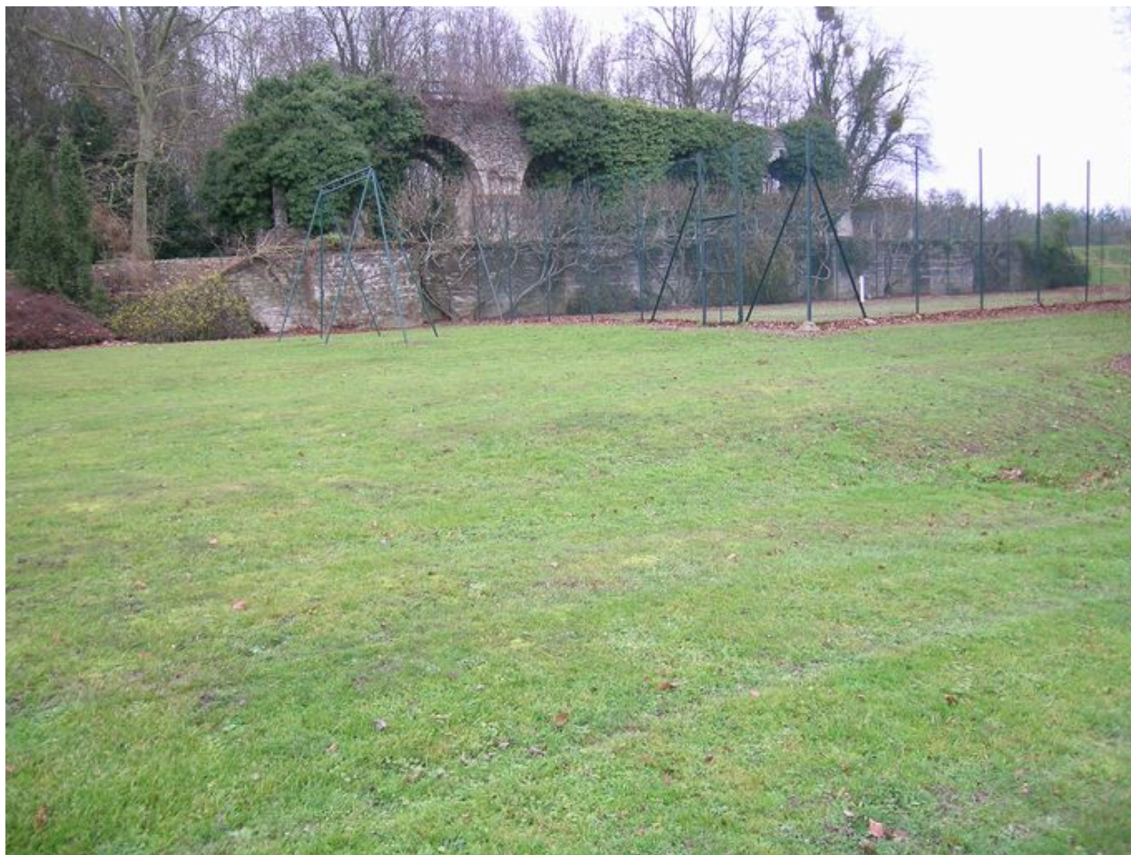
Arcades de l'ancien édifice
