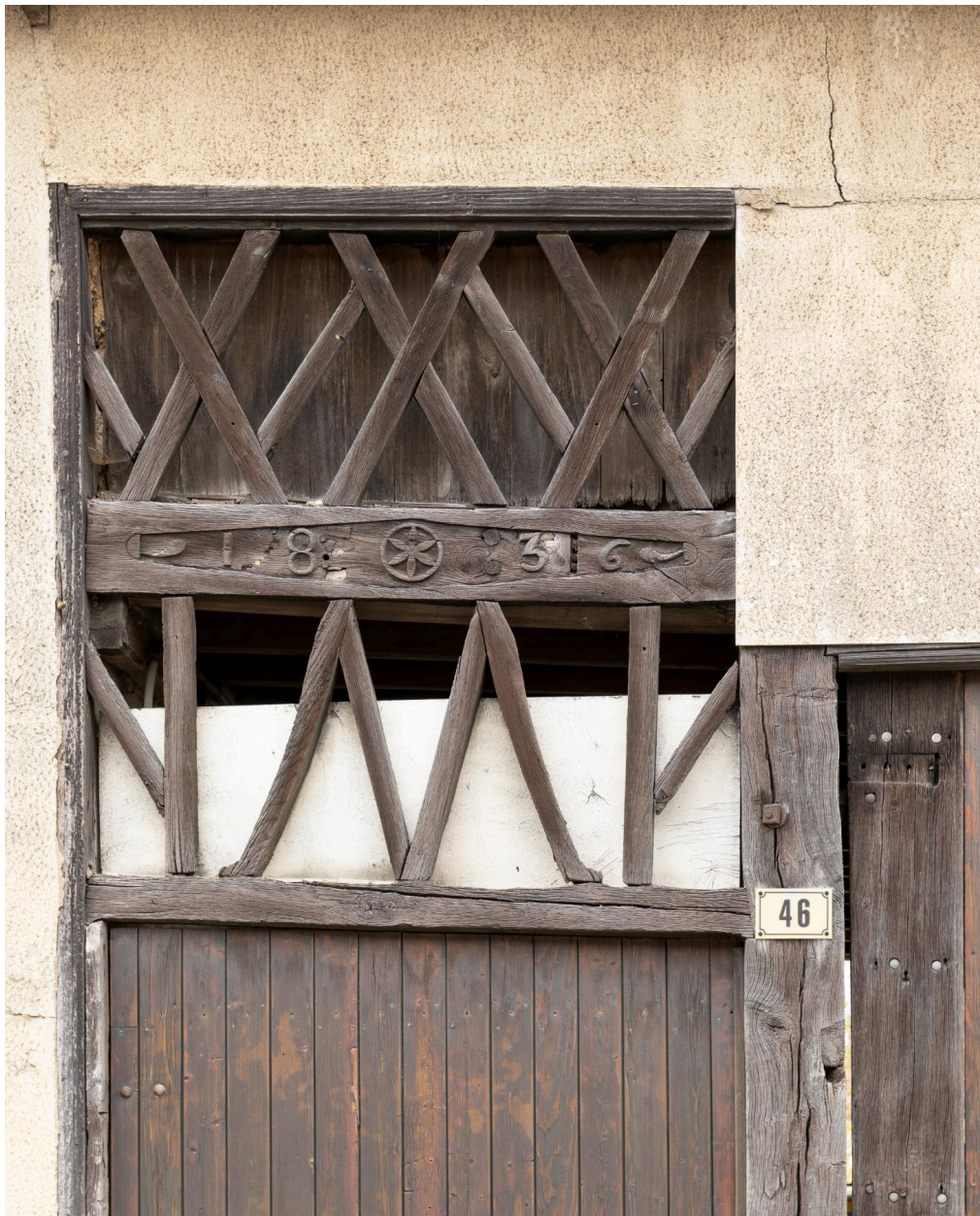
Imposte ajourée de l'entrée piétonne, n°46 rue de Beauvais.
