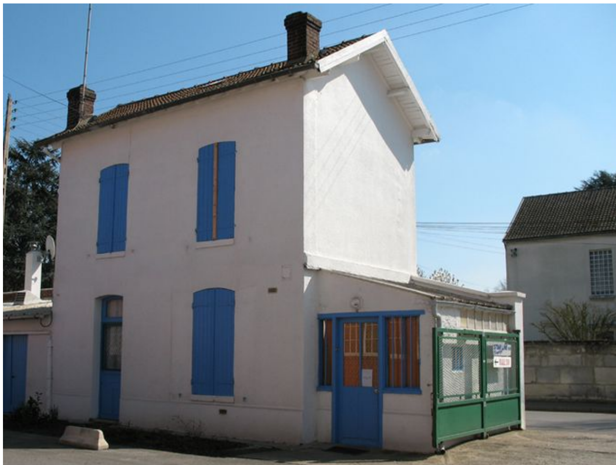
Le logement du concierge à l'entrée de l'usine.
