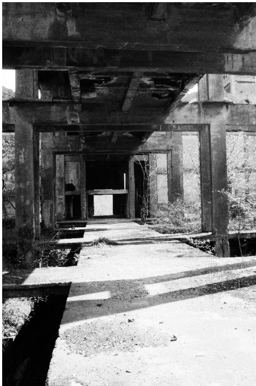
Atelier de fabrication, premier étage.
