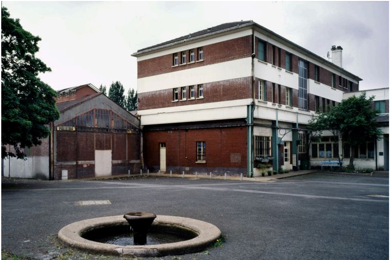
Ancien préau et bâtiment abritant la lingerie.
