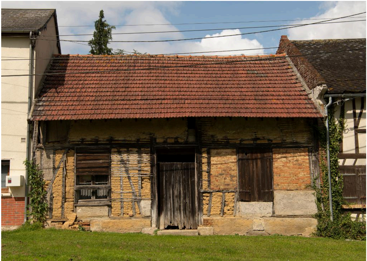
Ancienne maison, n°19 rue de l'Église, vue depuis l'est.
