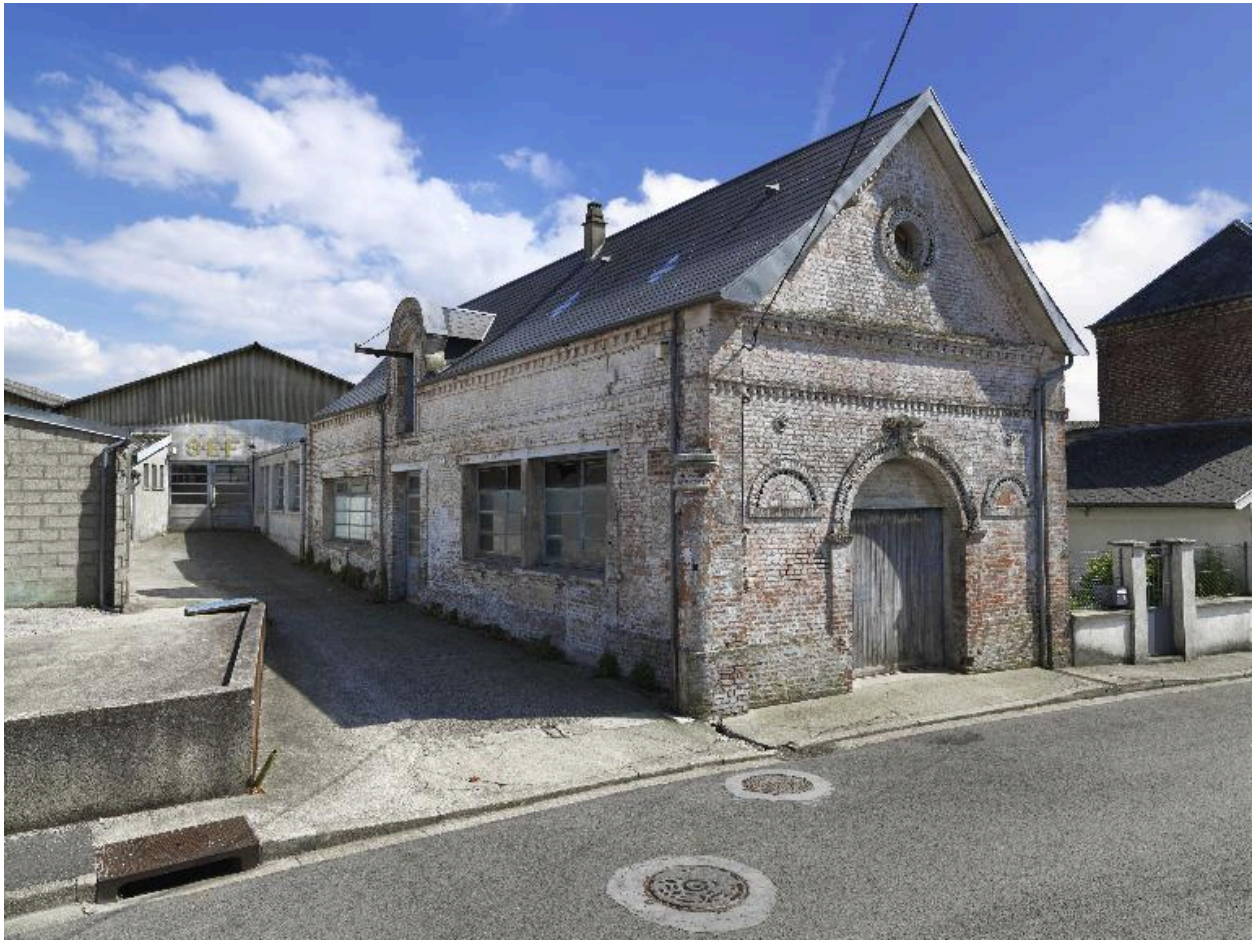
Vue de l'ancien entrepôt de marchand de vins transformé en atelier.
