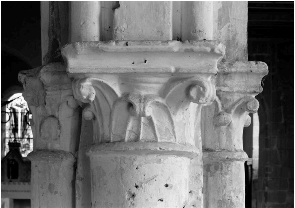
Bas-côté sud : détail d'un chapiteau.
