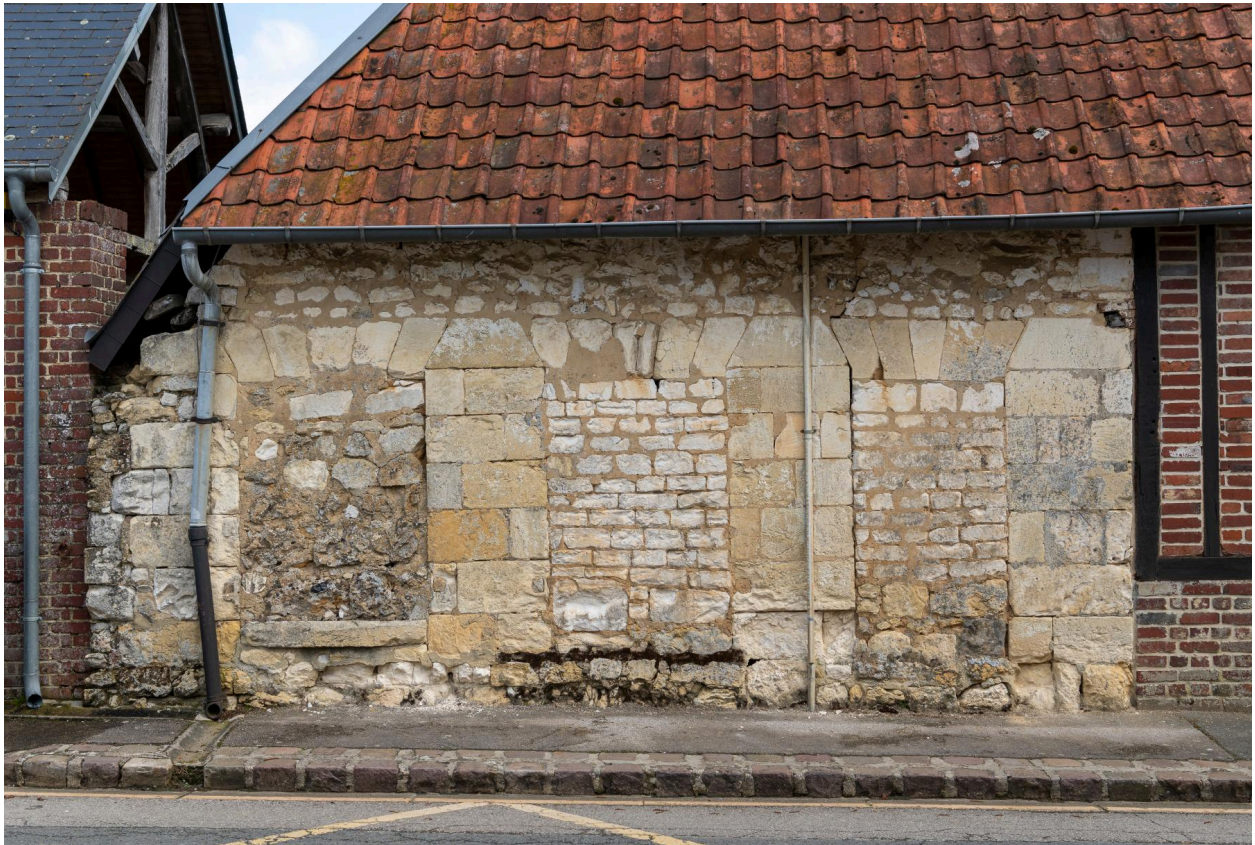
Ancienne école (?), n°87 de la Grande Rue, vue prise depuis le sud.
