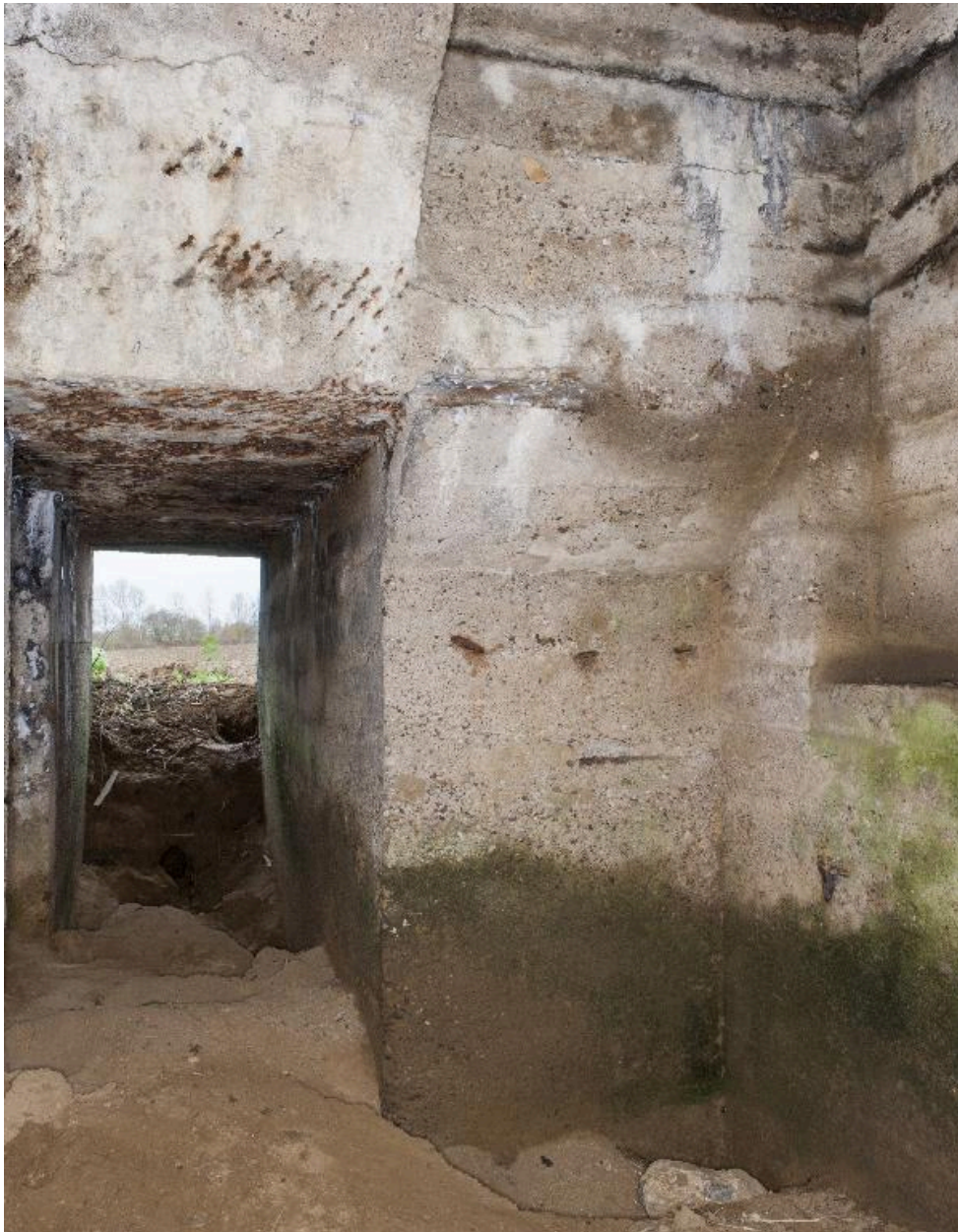
Couloir de distribution en enfilade
