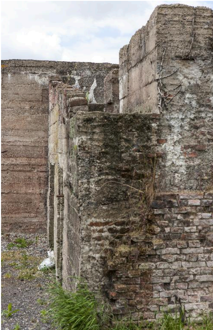
Pignon nord vers le sud-ouest. A droite le poste d'observation
