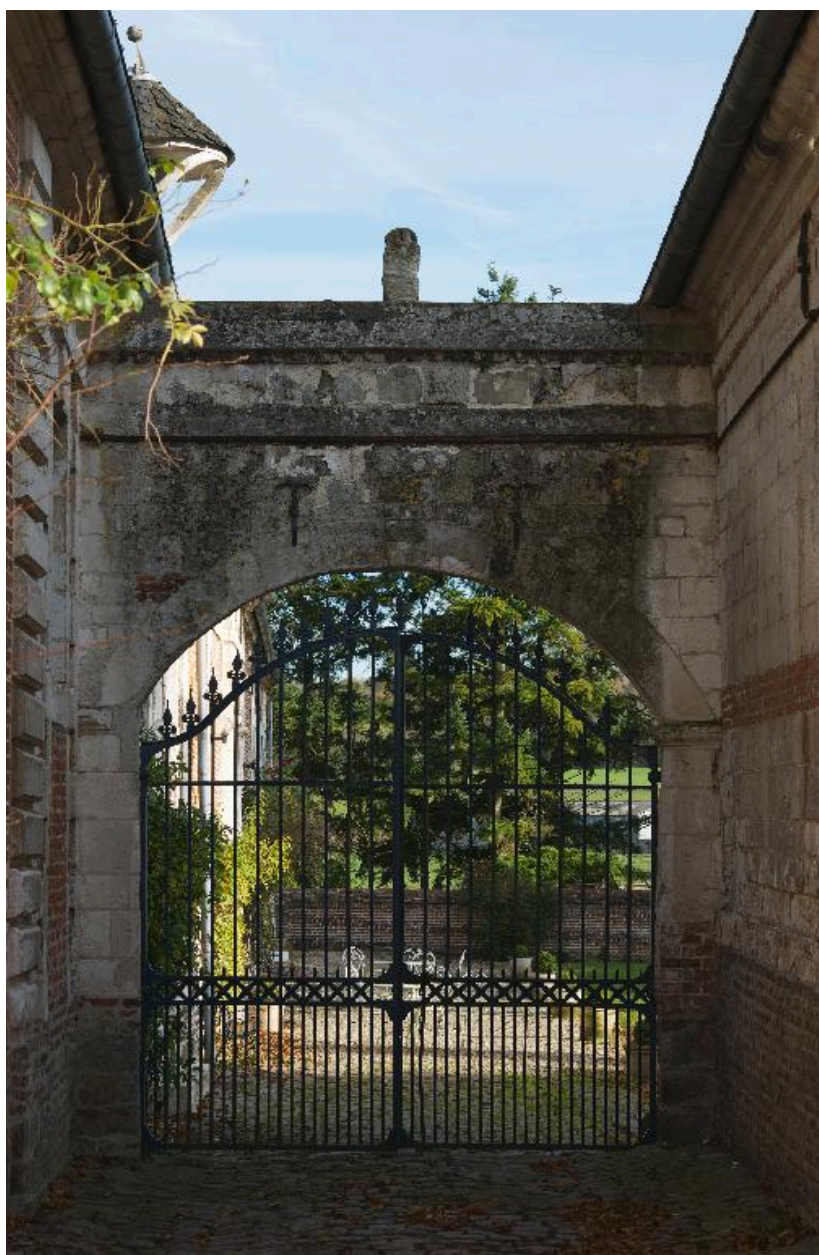
Porte entre la cour et la basse-cour.
