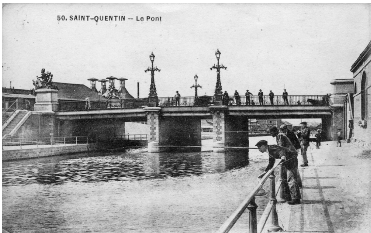
Le pont sur le Canal de Saint-Quentin vers 1900 : à gauche, les toitures de la malterie (BM Saint-Quentin).
