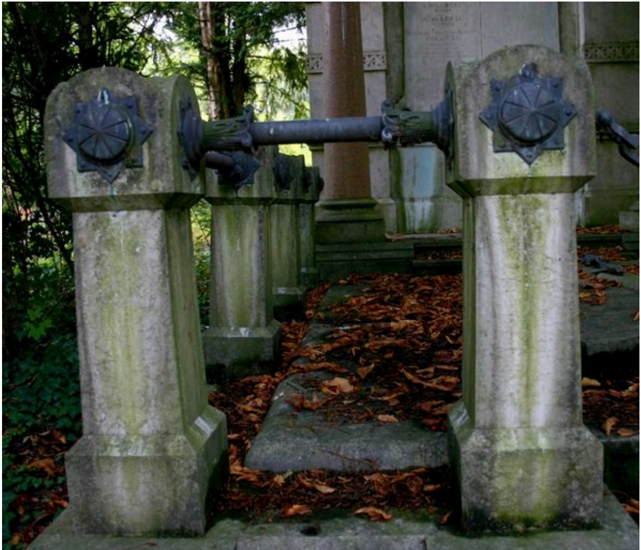
Détail des poteaux de clôture.
