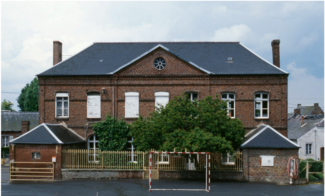
Vue générale depuis le sud.
