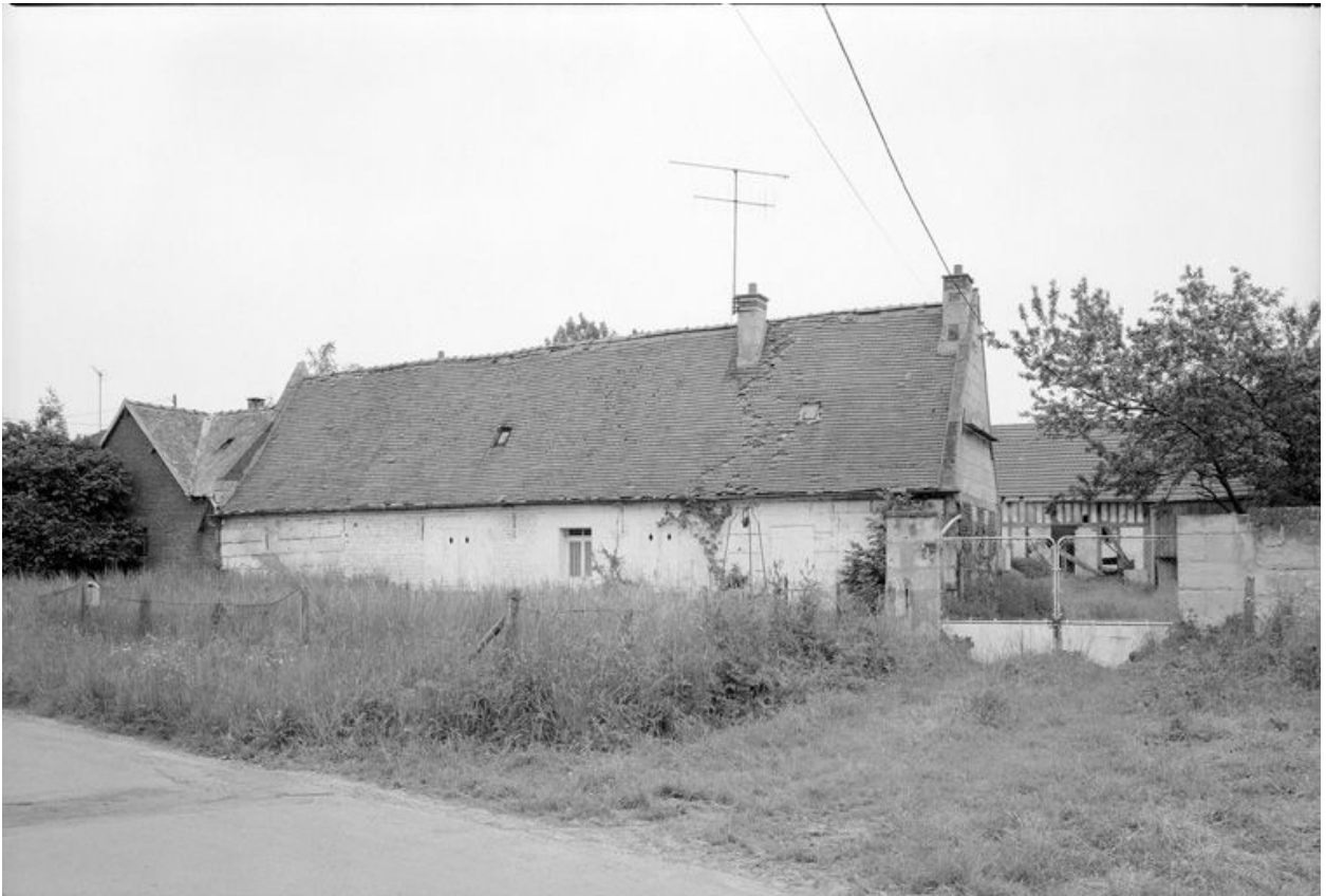
Logis. Élévation antérieure.
