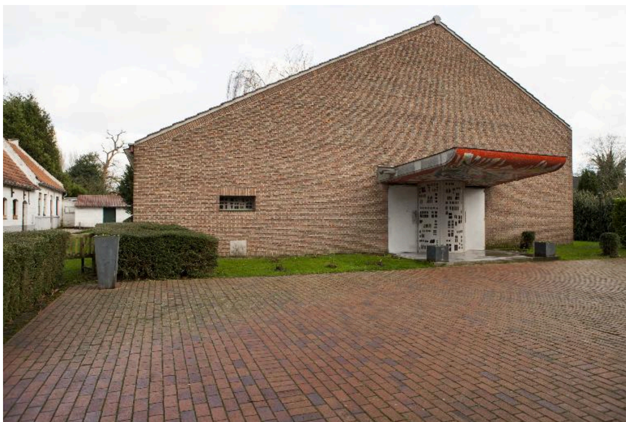
Élévation antérieure de la chapelle.
