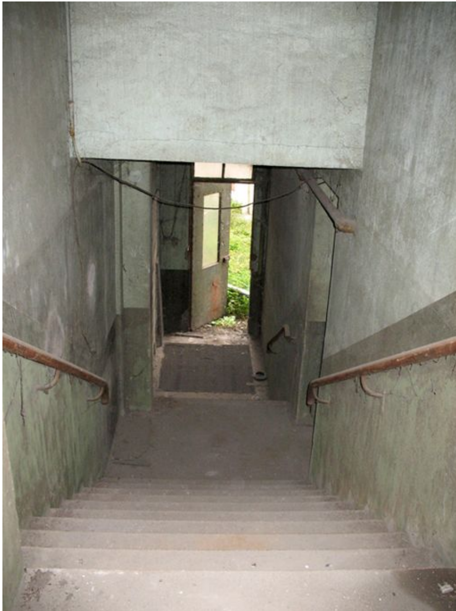
Escalier desservant les sanitaires et les vestiaires des ouvriers.
