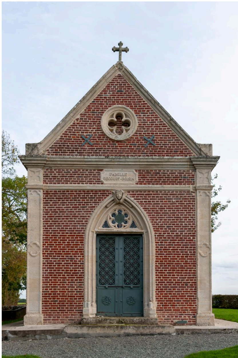
Façade de la chapelle.
