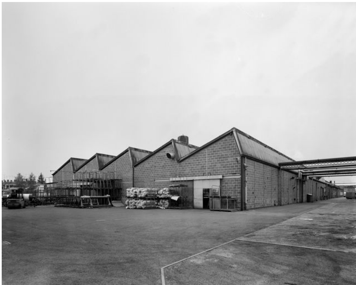
Atelier de fabrication (ancien chemin de la Ville le Marclet), en 1988.
