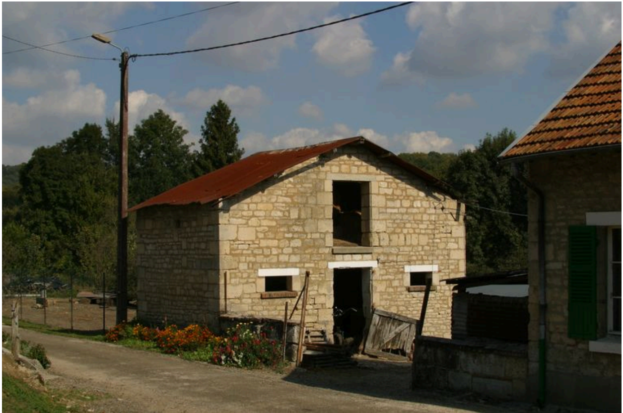
Vue de la grange postérieure au logis.
