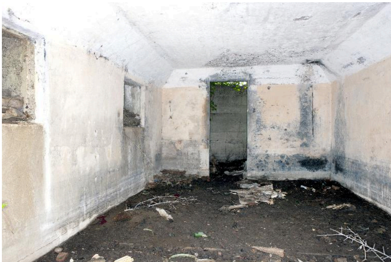
Intérieur de l'édifice depuis l'entrée nord
