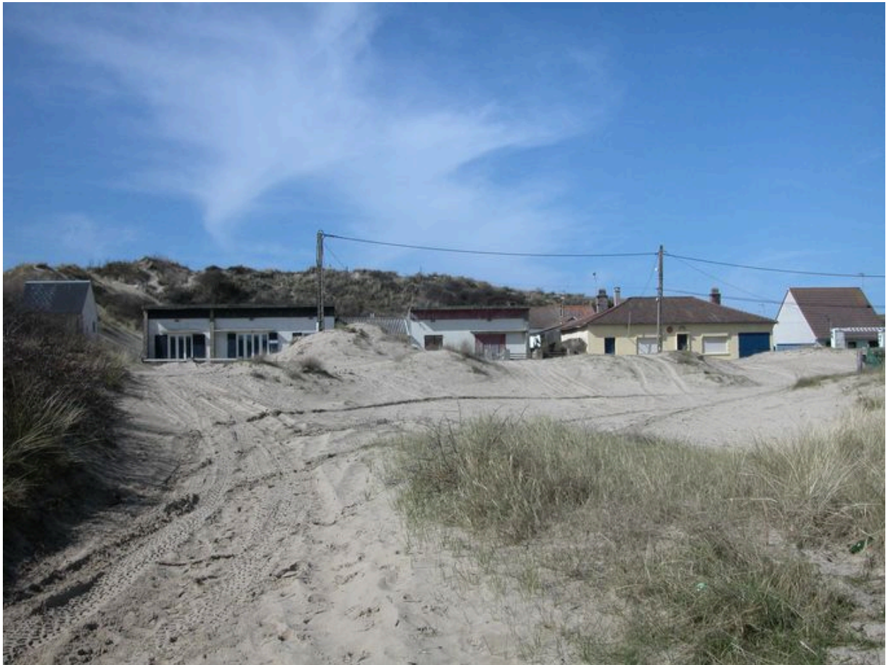
Les maisons au sud de l'îlot 18, vues depuis l'îlot 20.
