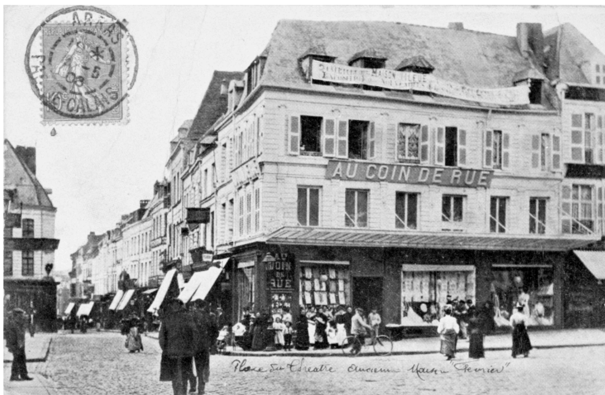
Arras. Place du Théâtre. Ancienne maison Février. Carte postale (AD Pas-de-Calais ; 38 FI 719).
