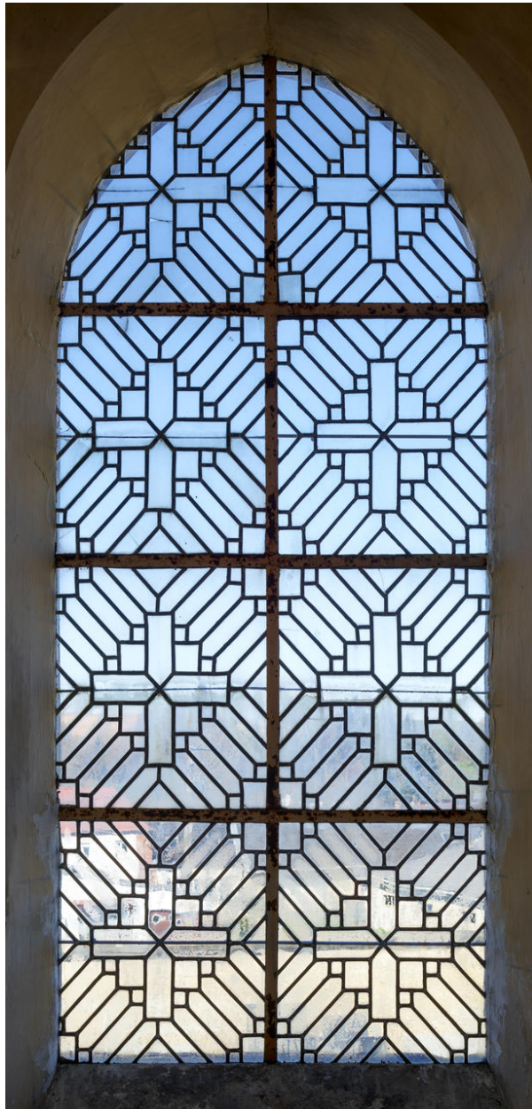
Verrière (baie 3) : verrière à borne.
