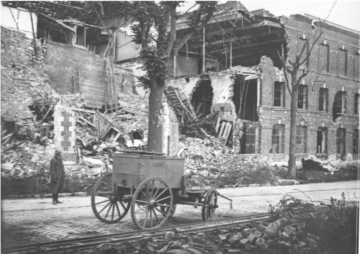
Les ateliers en ruine boulevard Victor-Hugo, 1918 (AC Saint-Quentin).
