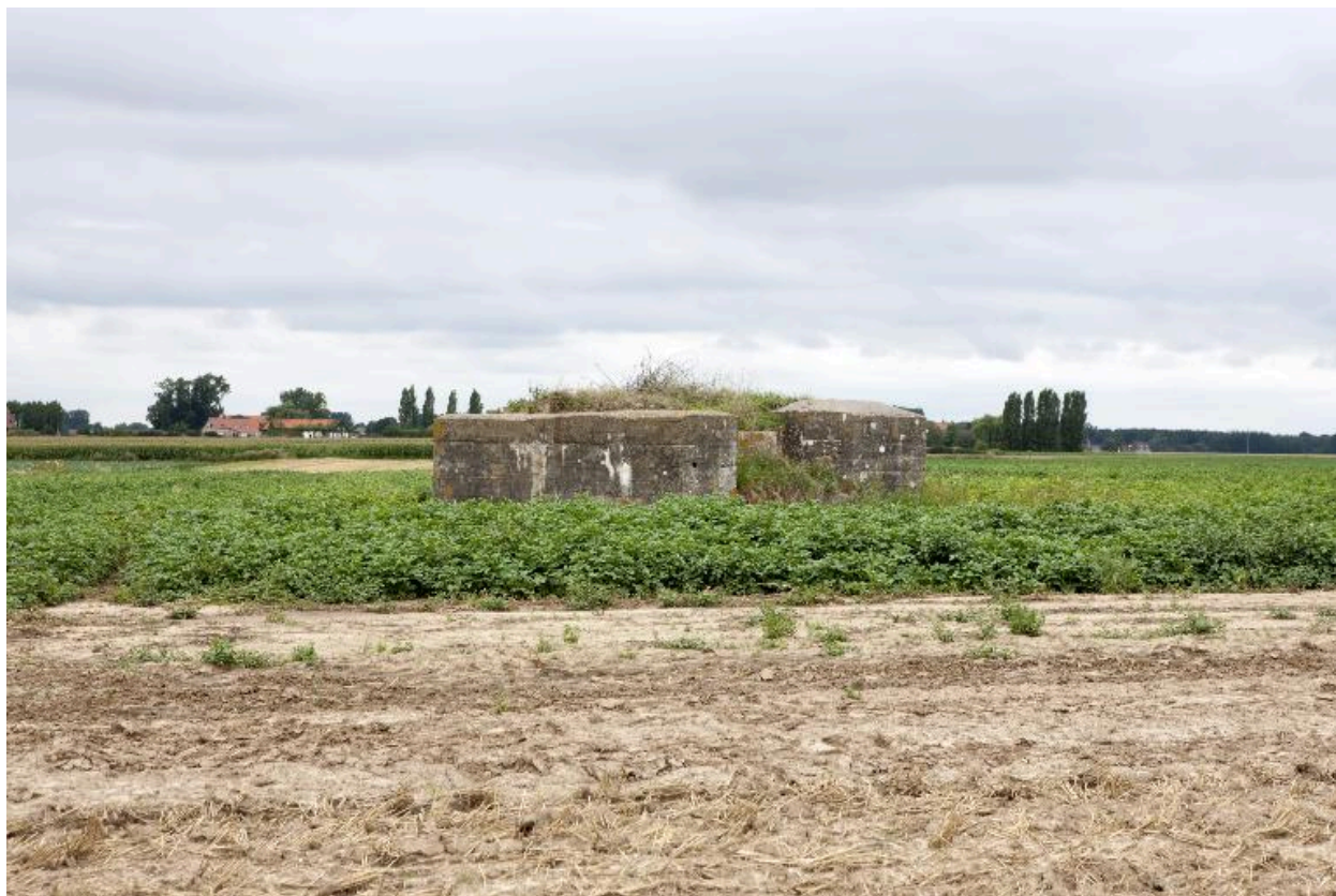
Vue générale vers le nord-ouest
