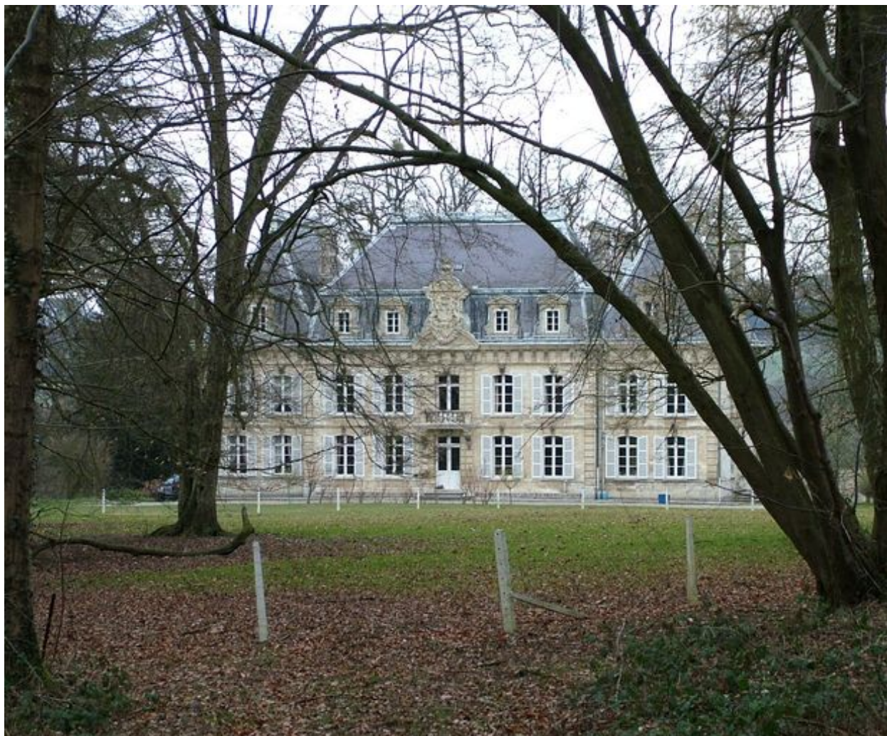
Façade postérieure depuis le parc.
