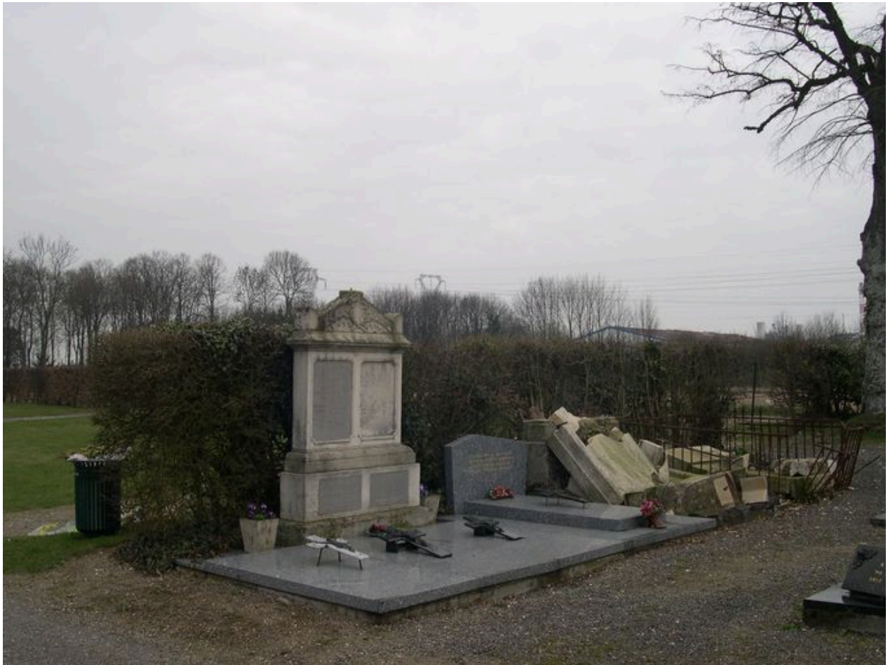
Partie ancienne du cimetière. Allée principale (rive nord). Tombeaux en mauvais état.
