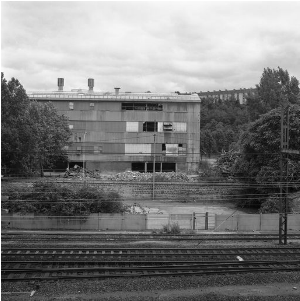
Démolition du bâtiment des fours, en 1999.
