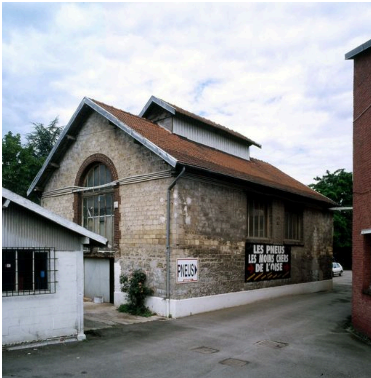
Bâtiment à lanterneau à l'entrée de l'usine.
