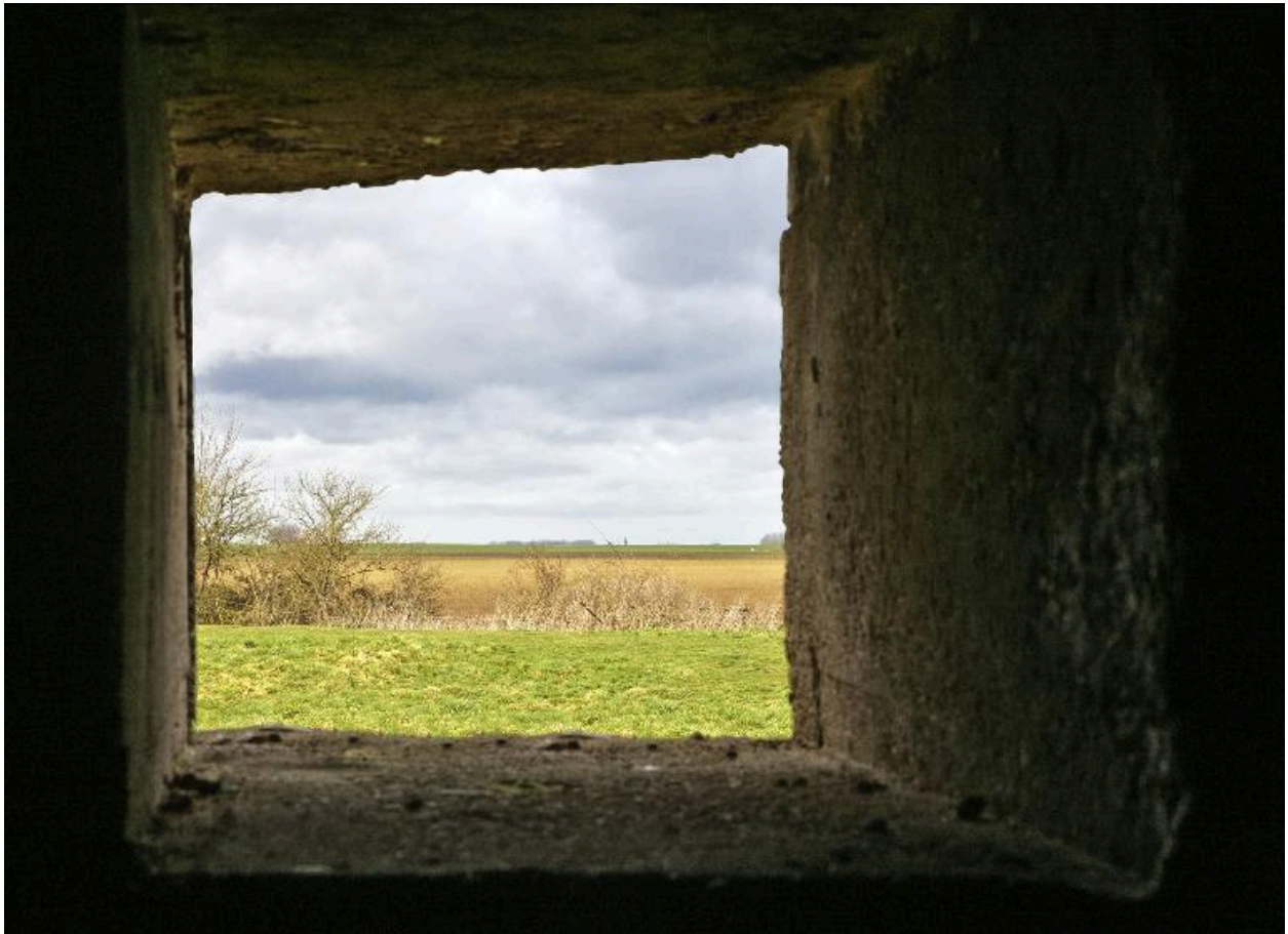
Vue intérieure, embrasure pour communication lumineuse pointant vers le sud-ouest
