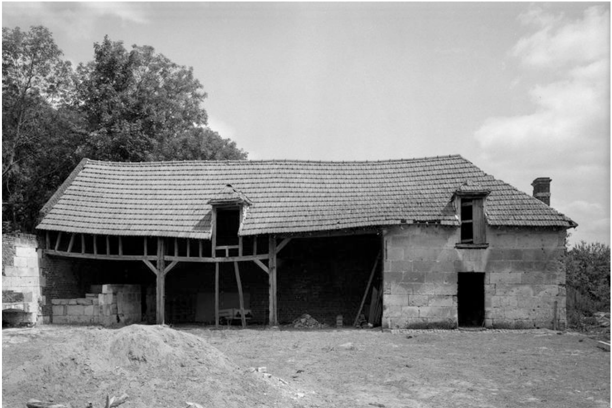
Grange et hangar.
