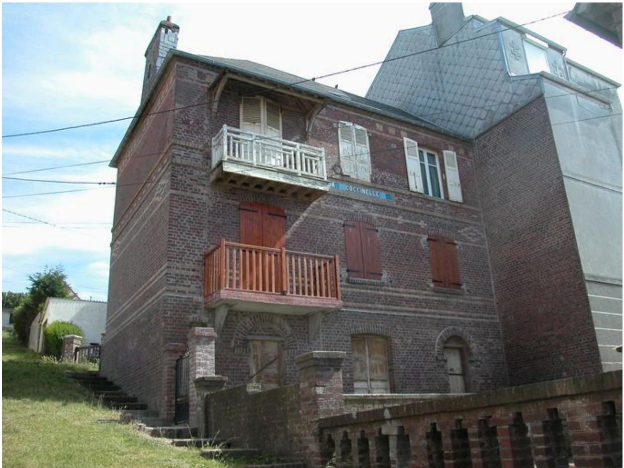
Vue de l'élévation postérieure, côté mer, depuis la rue Dingeon.
