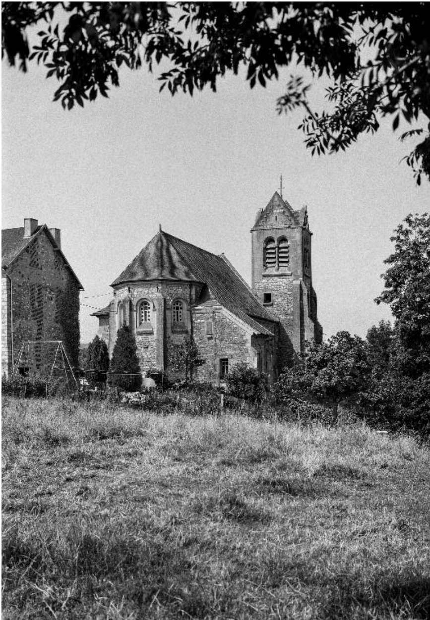
Vue d'ensemble de l'édifice depuis le nord-est.
