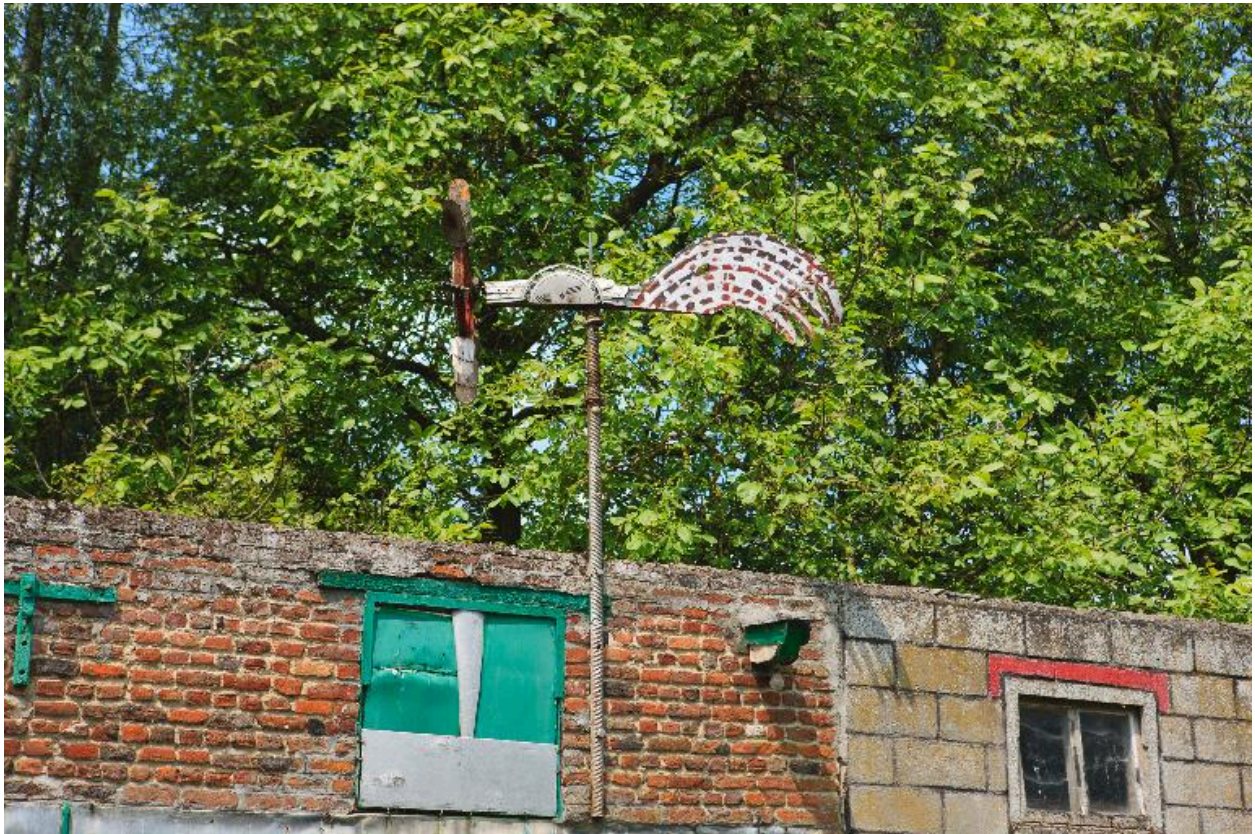
Vue partielle du bâtiment servant d'atelier.
