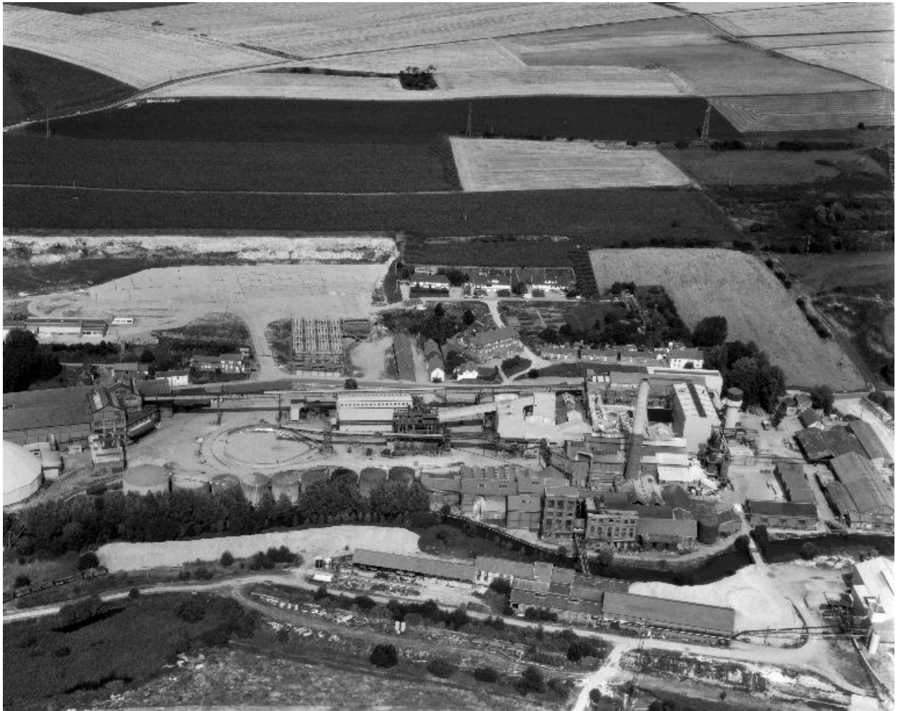
Vue aérienne, flanc sud-ouest.
