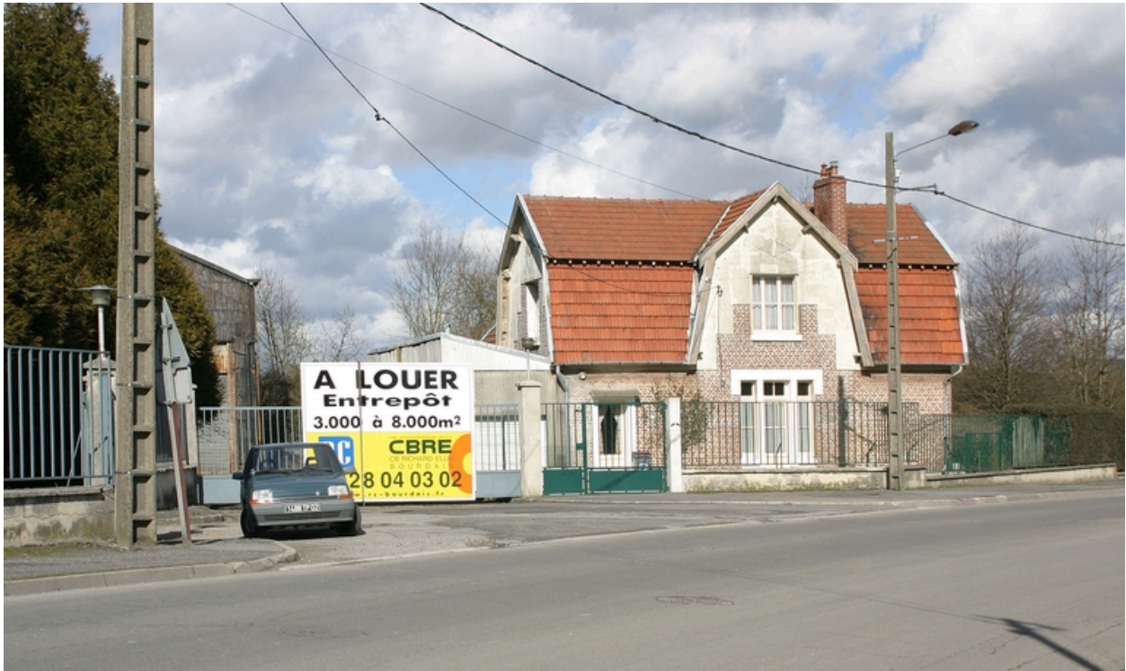
Entrée du site, route de Chauny.
