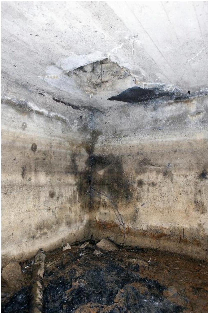
Salle S8, accès à la la tour de communication optique
